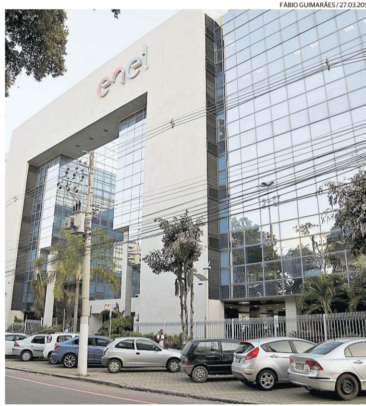
Enel já começou a emitir contas com nova opção de pagamento
